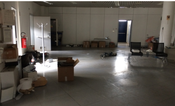
Vista interna unità commerciale
