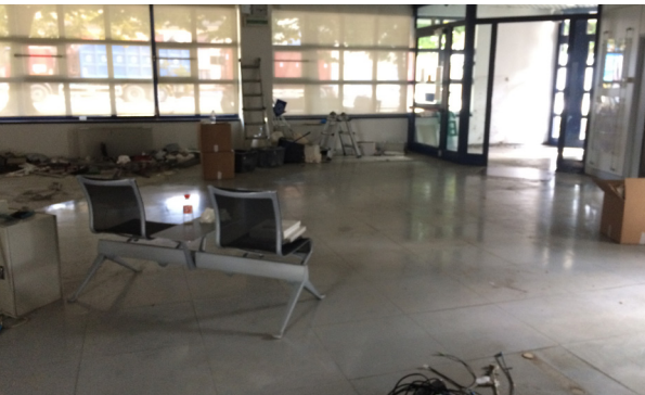
Vista interna unità commerciale
