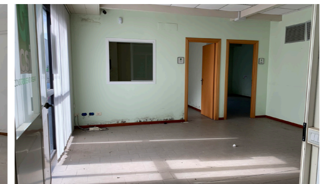
Vista interna unità artigianale/magazzino con uffici
