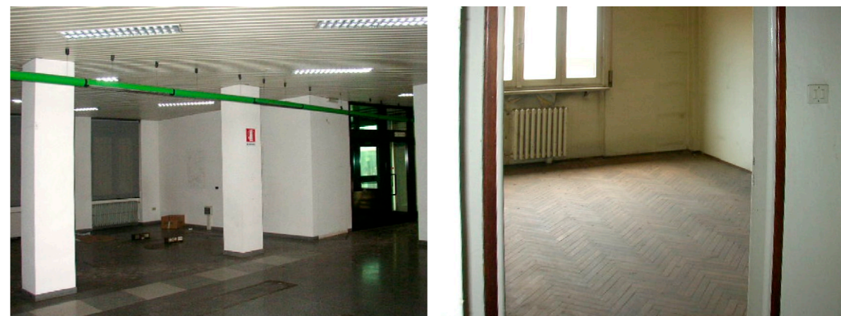
Vista interne ed esterne della proprietà
