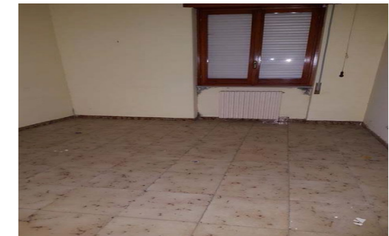
Vista interna unità residenziale
