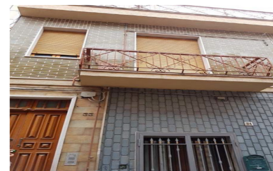
Vista esterna fabbricato
