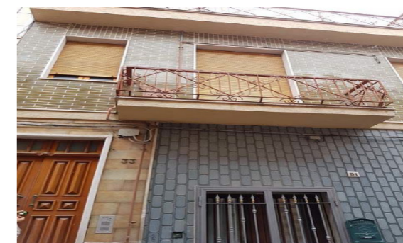
Vista esterna fabbricato
