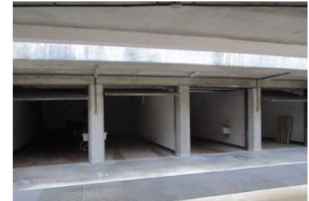
Vista generale garage
