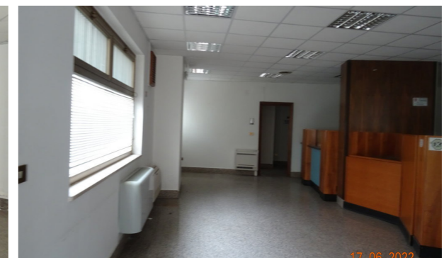
Vista interna unità commerciale/direzionale
