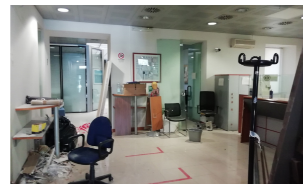
Vista interna unità direzionale/commerciale
