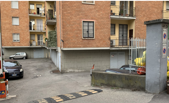
Vista esterna generale
