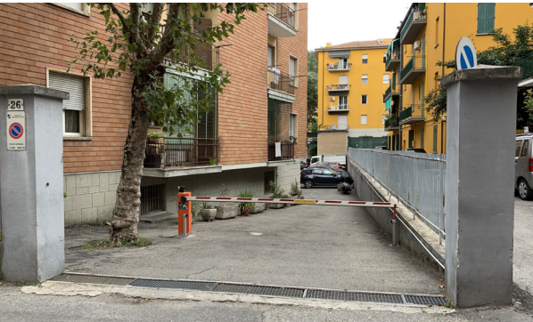
Vista esterna generale
