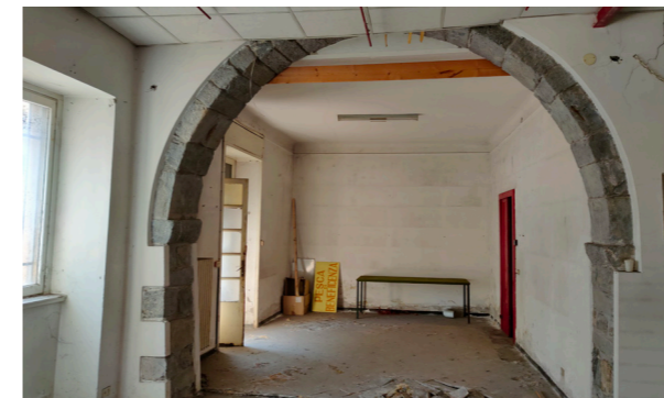
Vista interna unità commerciale
