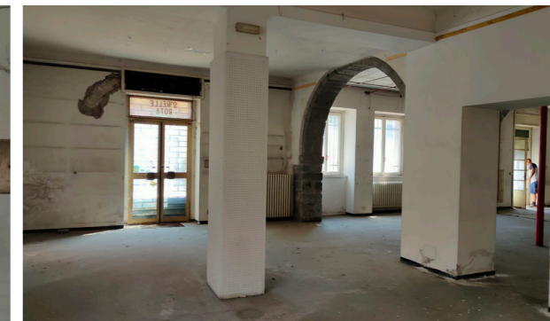
Vista interna unità commerciale
