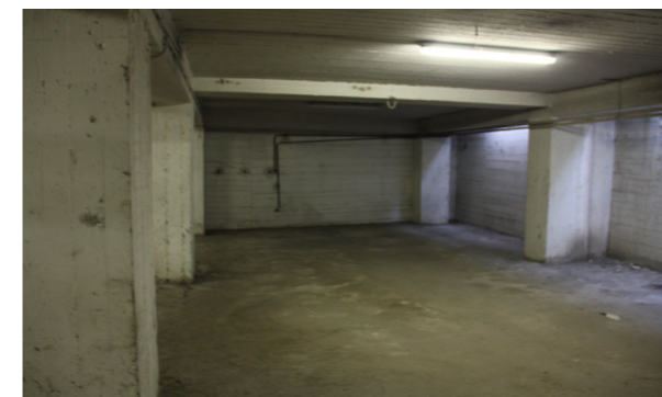
Vista interna unità commerciale
