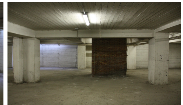
Vista interna unità commerciale
