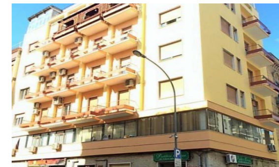
Vista esterna fabbricato
