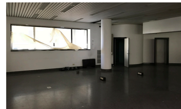
Vista interna unità commerciale
