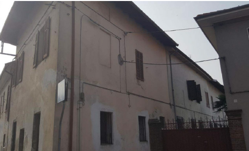
Vista esterna fabbricato
