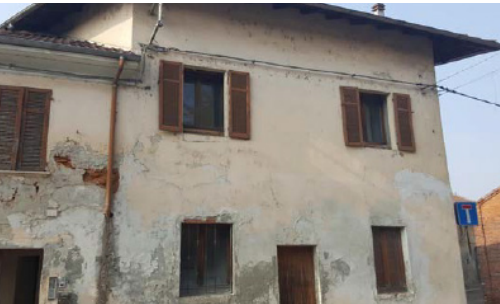
Vista esterna fabbricato
