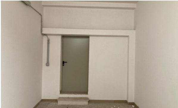
Vista interna unità ad uso deposito
