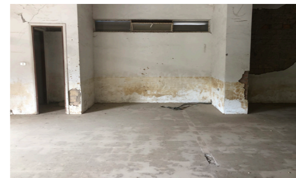
Vista interna unità commerciale
