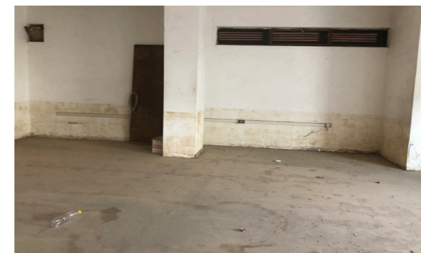
Vista interna unità commerciale
