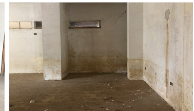
Vista interna unità commerciale
