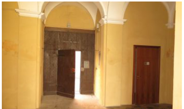
Vista interna unità commerciale
