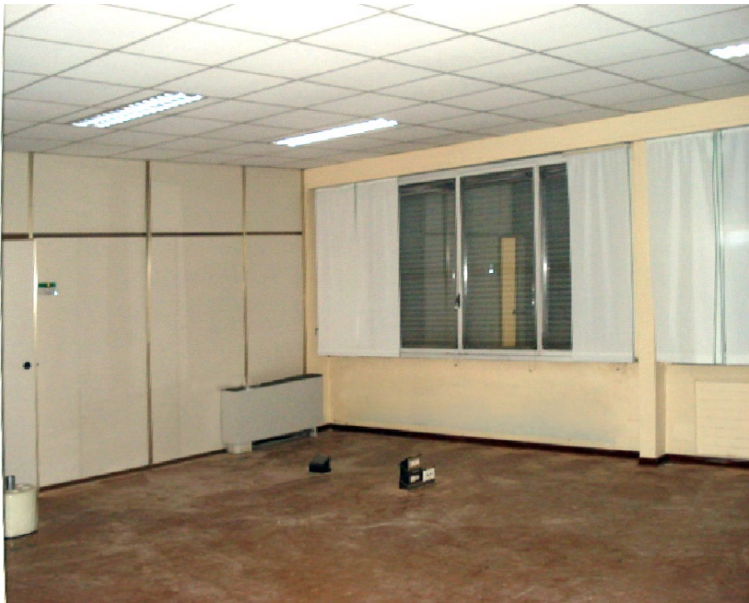
Vista interna della proprietà
