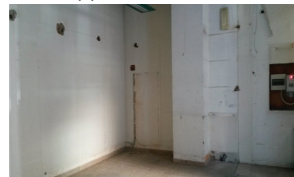
Vista interna della proprietà
