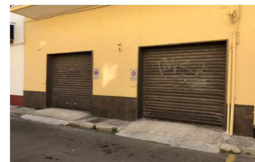
Vista esterna locale magazzino
