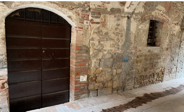
Vista esterna della cantina
