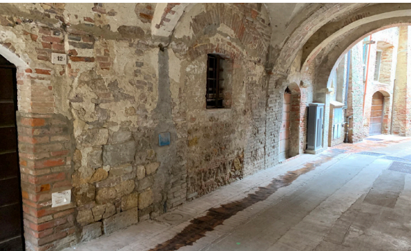
Vista esterna della cantina
