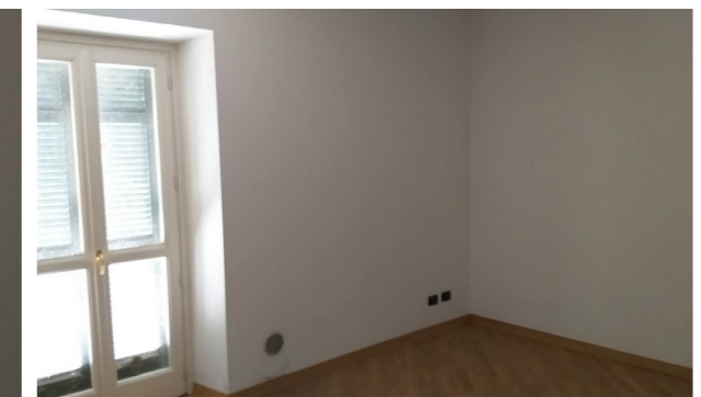
Vista interna unità residenziale
