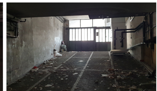
Vista interna autorimessa
