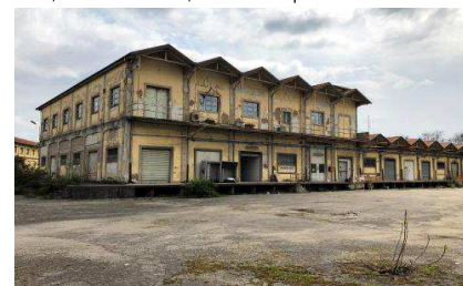
Vista esterna del compendio
