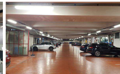
Vista interna dell'autorimessa
