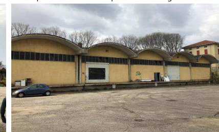
Vista esterna del compendio
