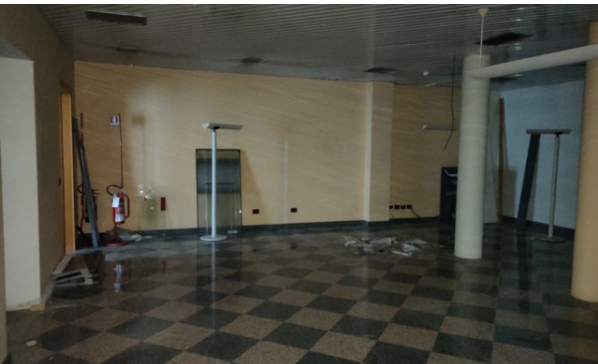
Vista interna unità direzionale
