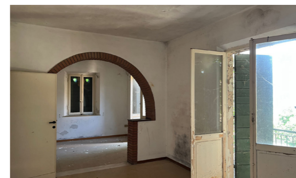
Vista interna unità direzionale
