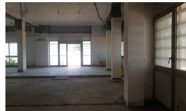
Vista interna unità commerciale/direzionale
