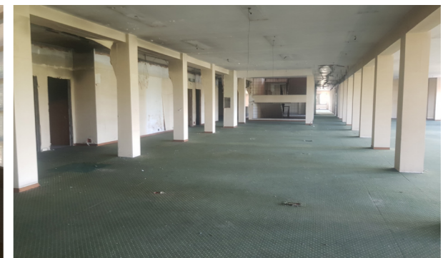
Vista interna unità commerciale/direzionale
