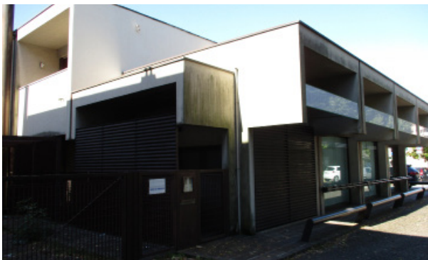
Vista esterna, lato est
