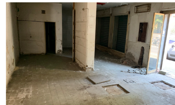
Vista interna unità commerciale
