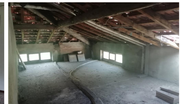
Vista interna sottotetto
