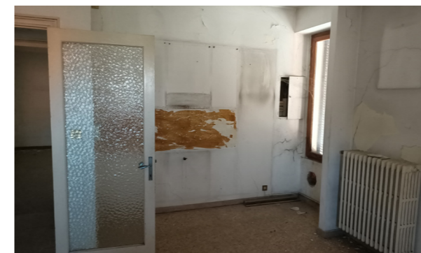
Vista interna unità residenziale
