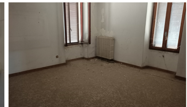
Vista interna unità residenziale
