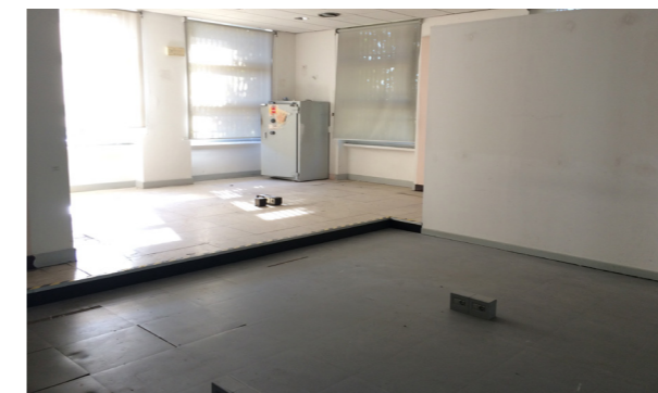
Vista interna unità commerciale
