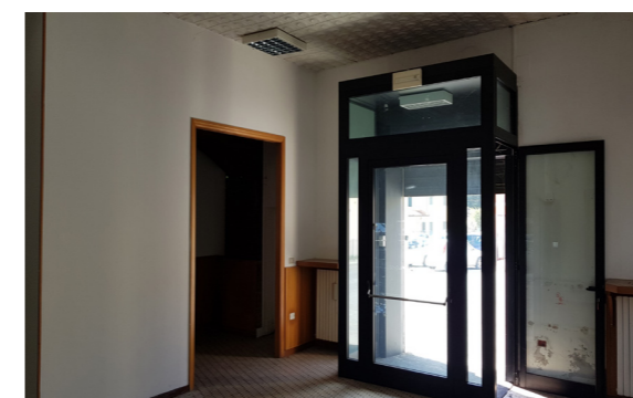
Vista interna unità commerciale
