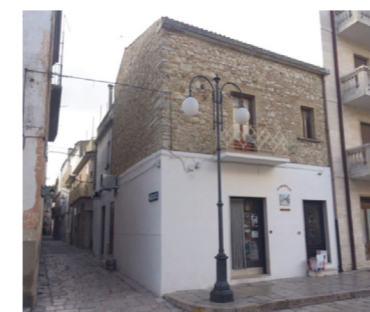
Vista Esterna Fabbricato
