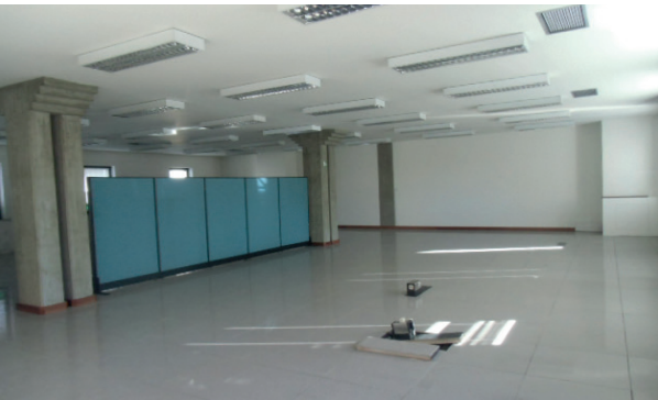
Vista interna unità commerciale
