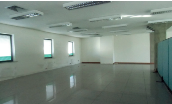
Vista interna unità commerciale
