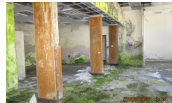
Vista interna unità commerciale/direzionale
