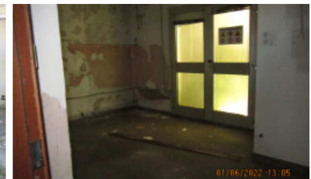
Vista interna unità commerciale/direzionale
