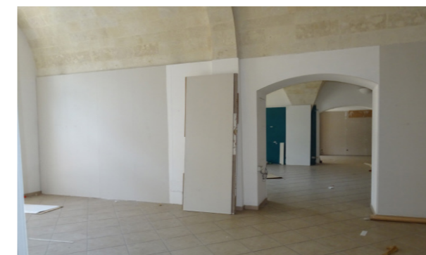
Vista interna unità commerciale
