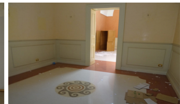
Vista interna unità residenziale
