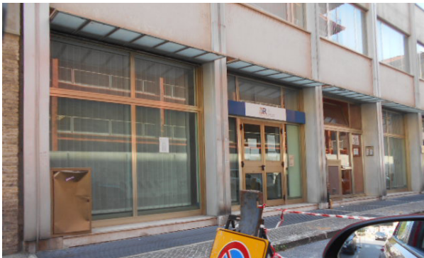
Vista esterna unità commerciale/direzionale
