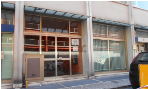
Vista esterna unità commerciale/direzionale
