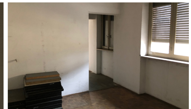
Vista interna unità commerciale
