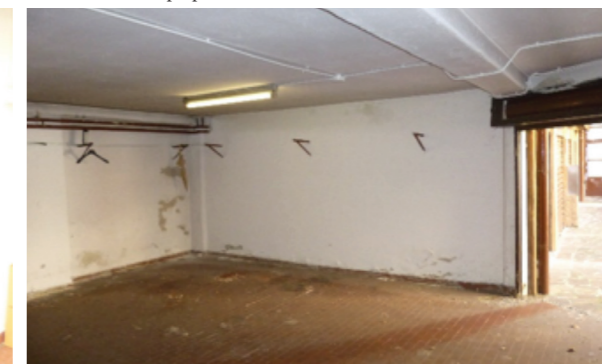
Vista interna della proprietà
