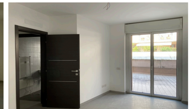
Vista interna unità residenziale
