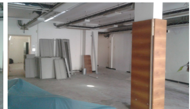
Vista interna unità commerciale
