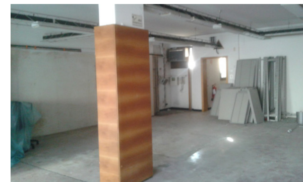
Vista interna unità commerciale
