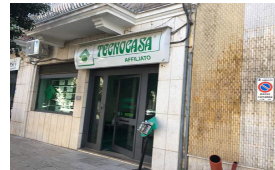
Vista esterna fabbricato
