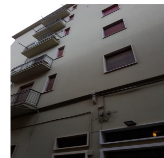
Vista esterna fabbricato
