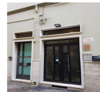
Vista esterna fabbricato
