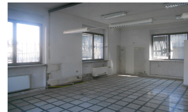
Vista interna unità commerciale
