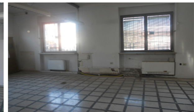
Vista interna unità commerciale
