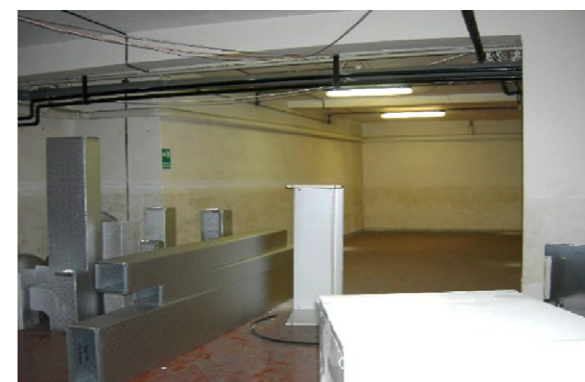
Vista interna della proprietà
