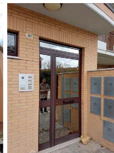
Vista esterna fabbricato
