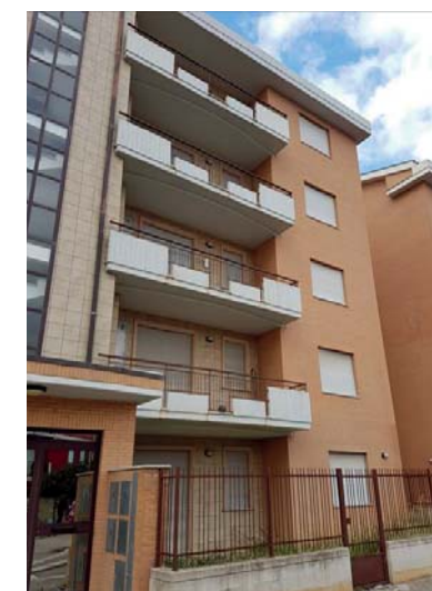
Vista esterna fabbricato
