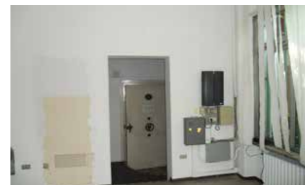
Vista interna della proprietà
