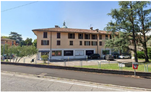
Vista esterna unità commerciale
