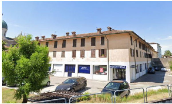
Vista esterna unità commerciale
