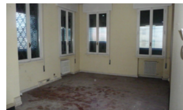
Vista interna della proprietà
